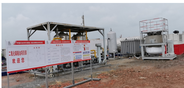
图6 干冰升华气相压注施工现场
