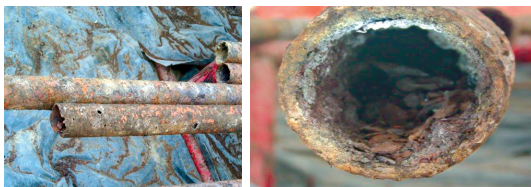
图1 T402井单元注气油管腐蚀
